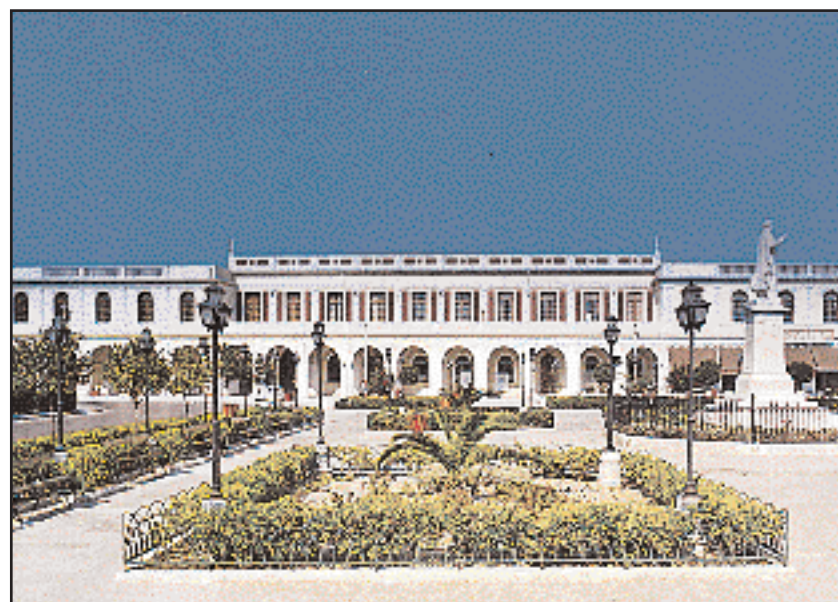
Στην πλατεία Σολωμού, το κτίριο του Δημοτικού Πνευματικού Κέντρου. Βρίσκεται στη θέση που ήταν άλλοτε το Δημοτικό Θέατρο. Στεγάζει τη Δημόσια Βιβλιοθήκη, το Ιστορικό Αρχείο και τον κινηματογράφο «Φώσκολο». Επίσης αίθουσα για αποκριάτικους χορούς, διαλέξεις, συναυλίες και θεατρικές παραστάσεις. (Φωτ. Στάθης Πισκαρδέλης).
