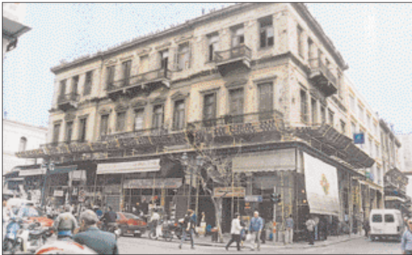
▲ Γωνία Αθηνάς και Ευριπίδων. Το επιβλητικό οικοδόμημα του πάλαι ποτέ ξενοδοχείου «Βενετία» με τη χαρακτηριστική έκφραση του αθηναϊκού κλασικισμού, όπως αυτός διαμορφώθηκε κατά το τελευταίο τέταρτο του 19ου αιώνα (φωτ.: Γιάννης Μπαρδόπουλος).
