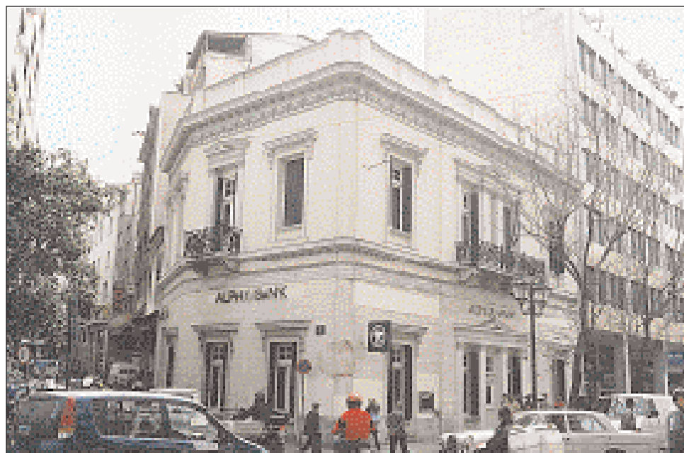
◀ Διώροφο νεοκλασικό οικοδόμημα στη γωνία Αθηνάς και Βορέου, σήμερα ανακαινισμένο ως υποκατάστημα της Alpha Bank. Τονισμός του άξονα της όψης προς την οδό Αθηνάς με ρυθμολογημένα, σύνθετα ανοίγματα και μαρμάρινο εξώστη στον όροφο (φωτ.: Γ. Μπαρδόπουλος).
