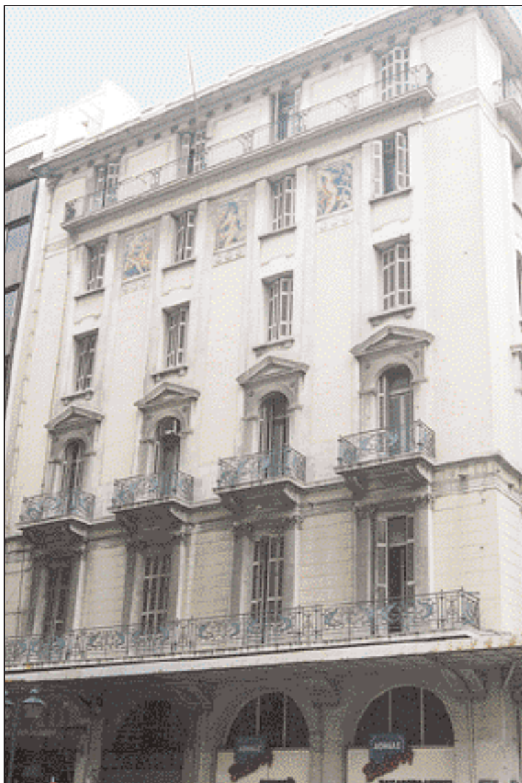
▲ Γωνία Αθηνάς και Ανκούργων: Επιβίωση του κλασικού πνεύματος κατά την περίοδο του μεσοπολέμου στο Μ.Τ.Η.Υ., έργο των αρχιτέκτονα καθηγητή Βασίλειου Κουρεμένου. Πρόκειται για προσθήκη σε προϋπάρχον νεοκλασικό οικοδόμημα (φωτ.: Γ. Μπαρδόπουλος).
