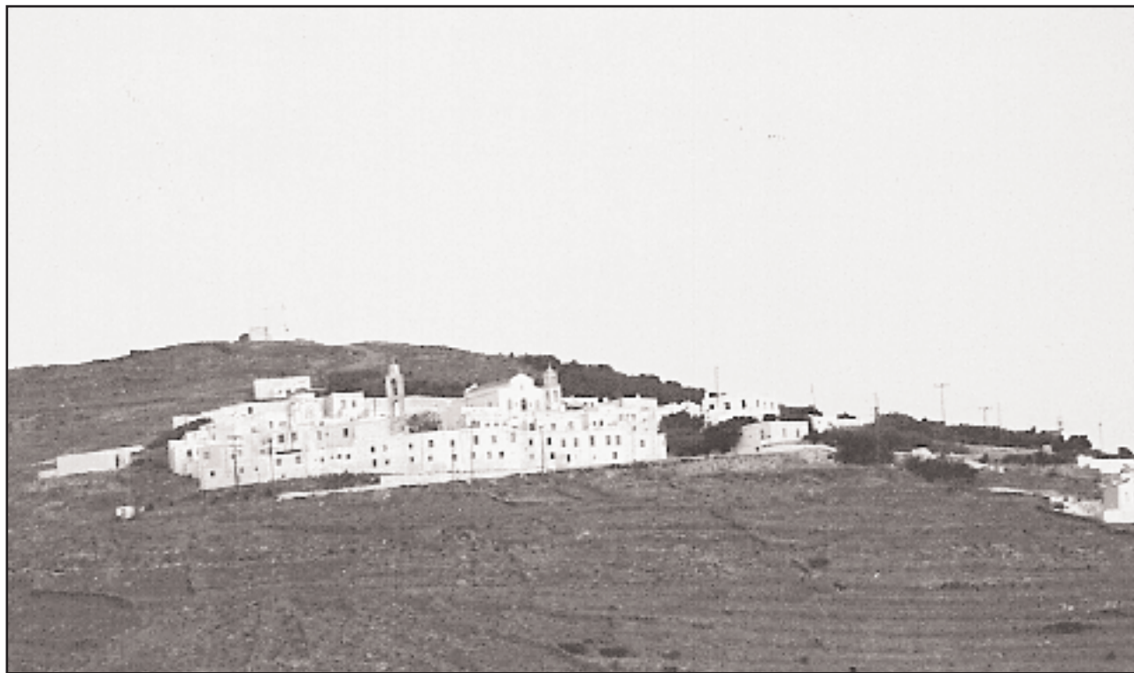
Γενική άποψη της Μονής του Κεχροβουνίου. Το συγκρότημα δίνει την εντύπωση κυκλαδίτικου χωριού, με κυβόσχημα σπίτια, στα οποία κατοικούν οι καλόγριες, στενούς δρόμους και μαρμάρινες βρύσες. (Φωτ. Ράνιας Η. Παπανικολάου).
