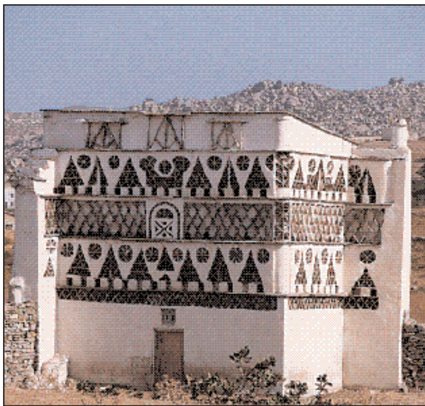
Περιστεριώνας στο χωριό Φαλατάδος, ασβεστωμένος, με την πορτούλα του. Η διακόσμηση καλύπτει πρακτικές ανάγκες. Και από την ανάγκη γεννιέται ένας πολιτισμός. (Φωτ. Ράνια Η. Παπανικολάου)
