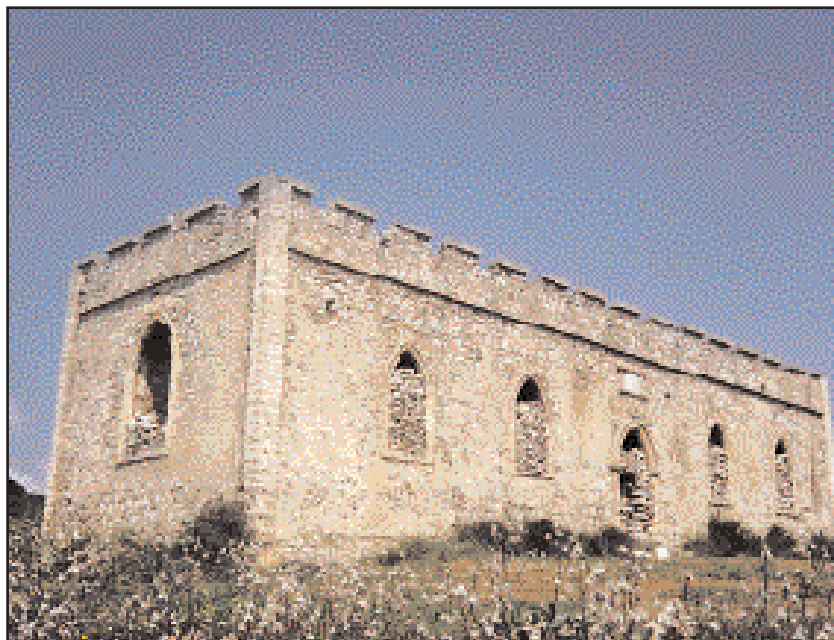
Ενα από τα σχολεία, που κατασκευάστηκαν επί Αγγλοκρατίας στα Κύθηρα. Βρίσκεται στο λόφο Μηλαπιδέα της περιοχής Λιβαδίου. Το σχολείο λειτουργούσε με τη Λαγγαστριανή (αλληλοδιδασκτική) μέθοδο. Το παράδοξο είναι, πως για να πεισθούν οι χωρικοί να στείλουν τα παιδιά τους στο σχολείο, τους εδόθη ως κίνητρο η απαλλαγή των ζώων τους από την αγγαρεία. Το μέτρο είχε μεγάλη επιτυχία, λόγω προφανώς της στενότητας στα μεταφορικά μέσα εν αντιθέσει με την αφθονία... παιδιών. Το πιο σημαντικό όμως αποτέλεσμα του ήταν η ταχύτερη άνοδος του μορφωτικού επιπέδου. Τότε έφθασαν τα Κύθηρα να έχουν το μεγαλύτερο ποσοστό γυναικών στα σχολεία απ' όλα τα Επτάνησα (φωτ.: Μαν. Καλλιγερου. Αρχ. εφημ. «ΚΥΘΗΡΑΪΚΑ»).
