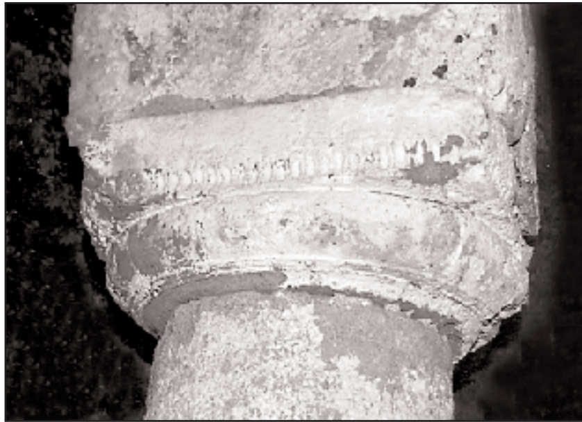
Πώρινα αρχιτεκτονικά μέλη από αρχαία κτίρια χρησιμοποιήθηκαν ως δομικό υλικό στην εκκλησία του Αγίου Κοσμά στο Παλιόκαστρο. Στη φωτογραφία αρχαϊκό δωρικό κιονόκρανο ενός από τους τέσσερις κίονες που υποβαστάζουν την καμάρα της εκκλησίας (φωτ.: Ι.Ε. Πετρόχειλου).
