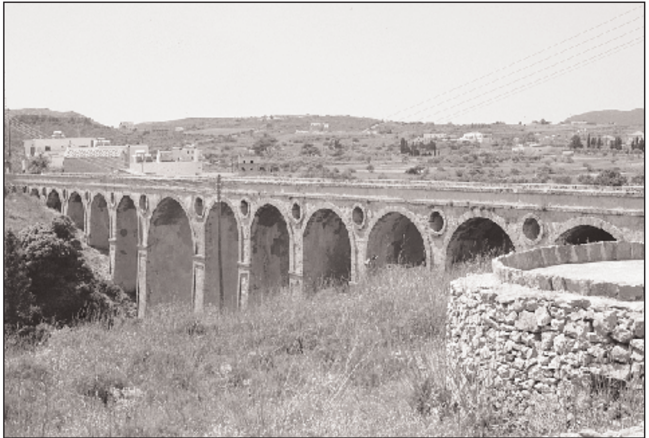
Γέφυρα Κατουνίου: Το πιο σημαντικό τεχνικό έργο επί Αγγλοκρατίας στα Κύθηρα είναι η γέφυρα στο Κατούνι. Σχεδιάστηκε και κατασκευάστηκε από τον Ταγματάρχη του Μηχανικού Μακφέιλ, τοποτηρητή του Αγγλου Αρμοστή στα Κύθηρα. Έχει 13 τόξα, 12 θυρίδες, μήκος 110 μ., ύψος 15 μ. και πλάτος 6 μ., είναι δε πιθανώς η μεγαλύτερη του είδους αυτού στην Ελλάδα. Ολο το έργο κατασκευάστηκε με τη μέθοδο της αγγαρείας (επίταξη εργασίας και μεταφορικών μέσων) και ολοκληρώθηκε το 1826, ελάχιστο χρόνο πριν από την οριστική κατάργησή της, λόγω των σφοδρών διαμαρτυριών των κατοίκων. (Με την ίδια μέθοδο πάντως κατασκευάστηκαν τότε και πολλά άλλα έργα, ιδίως οικοδομικά και οδικά) (φωτ.: Κ. Λιόντης).
