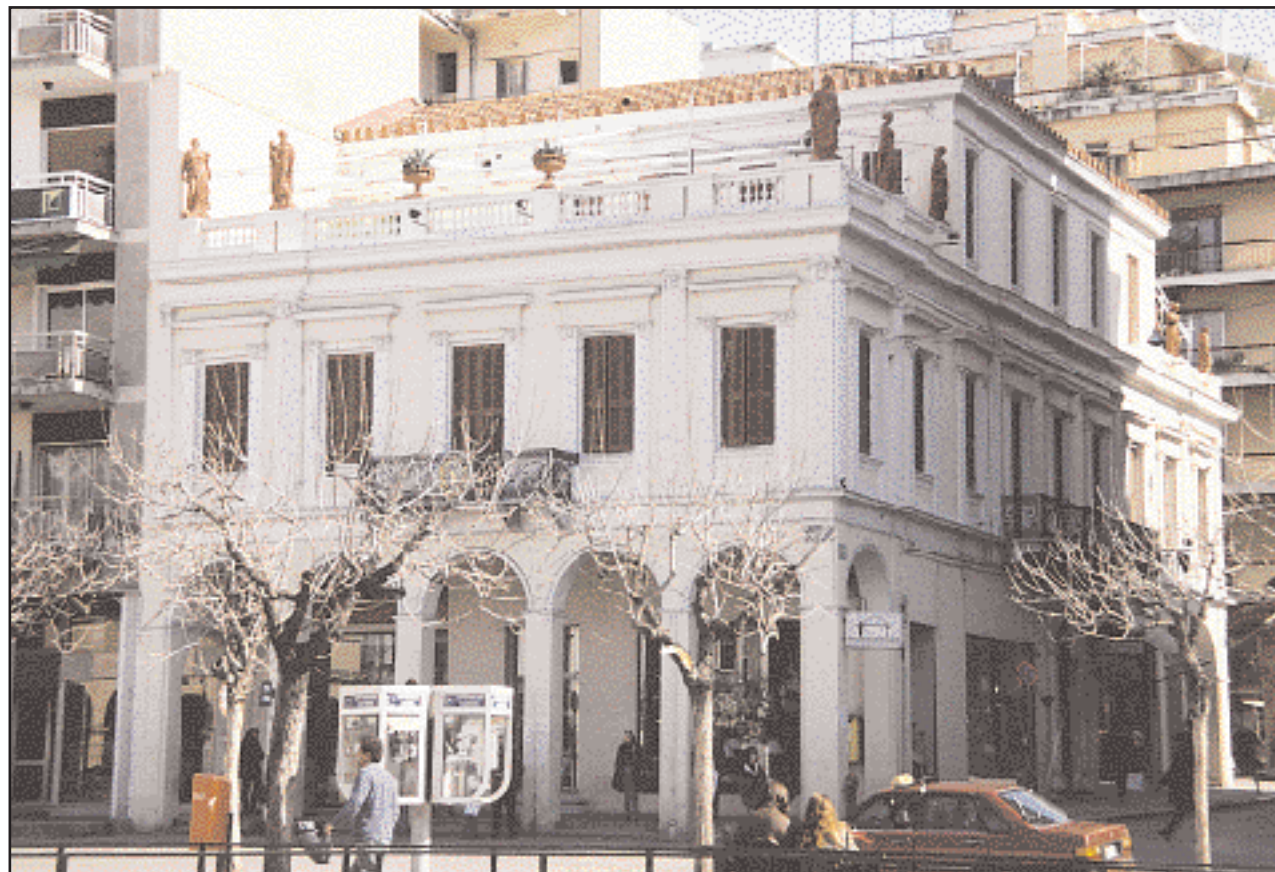
Κτίριο Εξαγωγικού Εμπορίου «Ερμής». Οικία του μεγαλεμπόρου και εφοπλιστού Παπαγιάννη, επί της πλατείας Γεωργίου της δεκαετίας 1870-80, αξιολογότερο νεοκλασικό με θαυμάσιες οροφωγραφίες.
