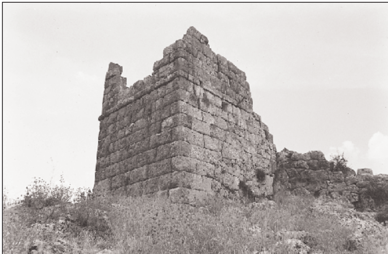
Ο Κοκκινόπυργος των Οινιάδων. Κατά την επανατίχιση των πόλεων από τον Φίλιππο τον Ε', οι πύργοι των ακαρνανικών πόλεων αποκτούν επιβλητικές διαστάσεις. Διακρίνεται το πλέξιμο των πολυγωνικών και ορθογωνικών λίθων στο σημείο επαφής του πύργου με το παλαιότερο τείχος (φωτ.: Δημήτρης Σ. Παπακωνσταντίνου).
