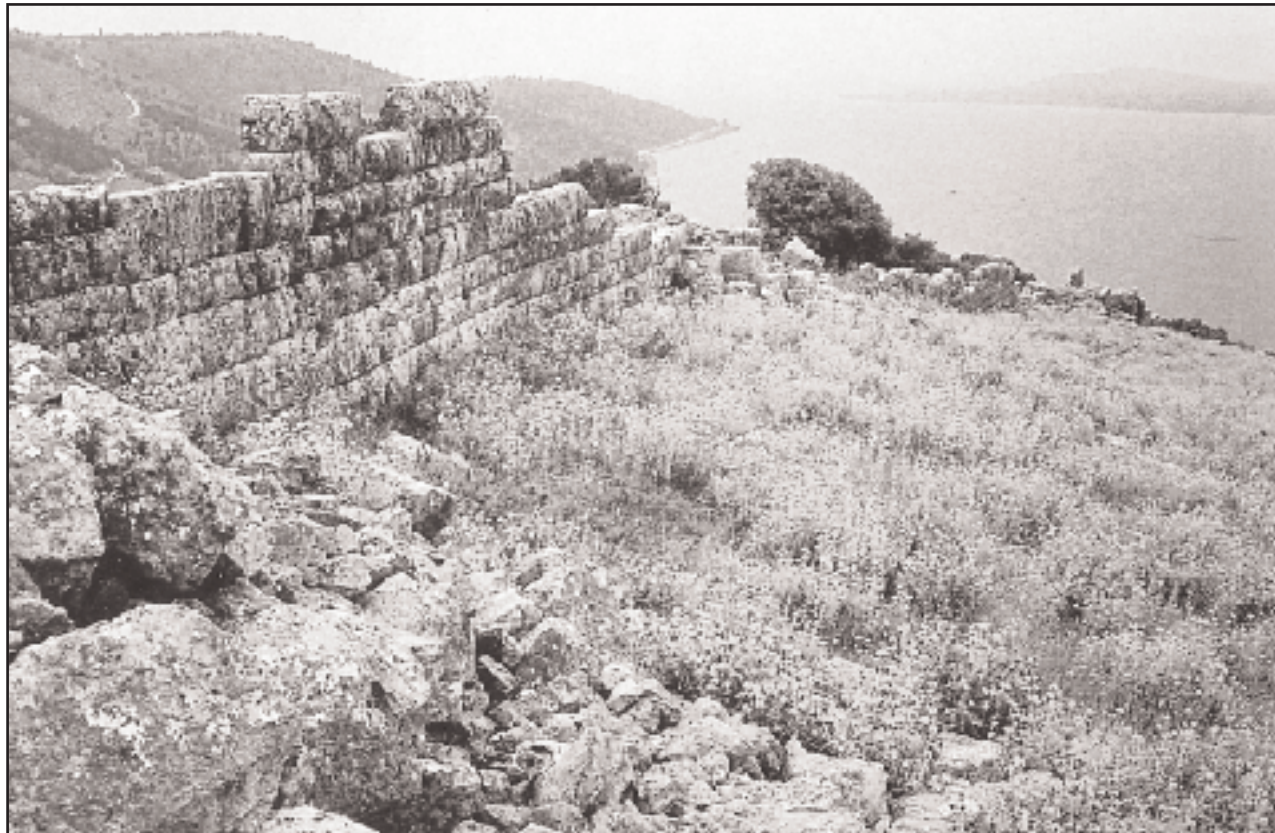
Αρχαία Λιμναία. Τμήμα ενός των ευθυγράμμων σκελών του τείχους που ξεκινούν από την ακρόπολη και κατεβαίνουν μέχρι τη θάλασσα. Χτισμένη στην κορυφή ενός λόφου στον μυχό του Αμβρακικού Κόλπου, πάνω από την Αμφιλοχία, ήλεγχε το πέρασμα προς τη λεκάνη του Αχελώου (φωτ.: Λάζαρος Κολώνας).
