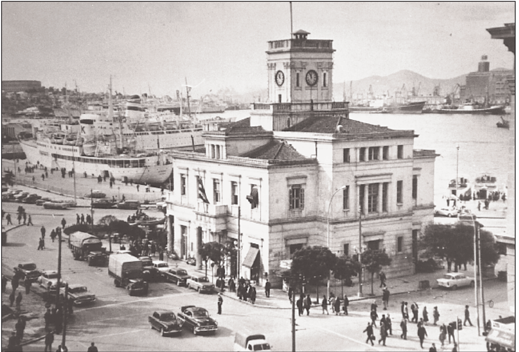
Το Χρηματιστήριο εμπορευμάτων, το αποκαλούμενο «Ρολόι», ήταν άλλοτε το κτίριο-σύμβολο της πόλης. Το κτίσιμό του ολοκληρώθηκε το 1873, ενώ από το 1880 στέγαζε το δημαρχείο της πόλης. Κατεδαφίστηκε στη δεκαετία του 1970. (Ιστορικό Αρχείο Δήμου Πειραιώς).
