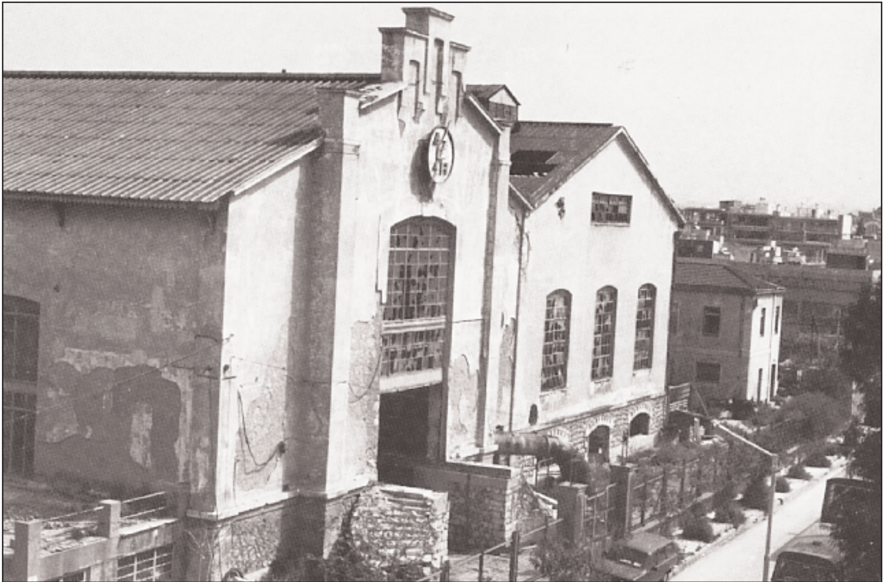
Το παλιό εργοστάσιο της ΔΕΗ, η πρώτη μεγάλη μονάδα παραγωγής ηλεκτρικής ενέργειας από το 1906, στο Ν. Φάληρο.
