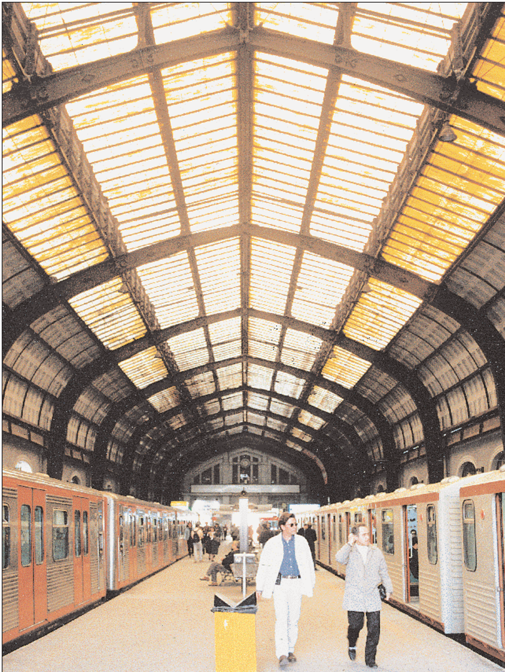
Γυαλί και ατσάλι με αρθρωτές συνδέσεις στεγάζουν την αποβάθρα επιβατών, του Ηλεκτρικού Σταθμού Πειραιώς. Η τέλεια ελαστική κατασκευή άντεξε στις βόμβες που έπεσαν στο εσωτερικό της κατά τον βομβαρδισμό του λιμανιού το 1944. (Φωτ. Γ. Κανελλόπουλος)
