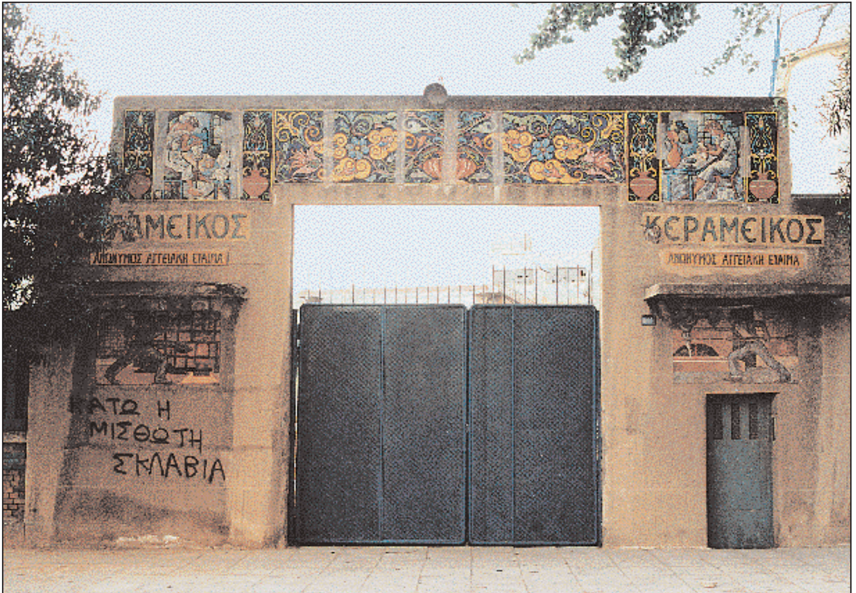
Ελάχιστο απομεινάρει του 1910, η Πύλη του «Κεραμεικού» από το ομώνυμο μεγάλο βιομηχανικό συγκρότημα. Μια δυναμική αρχιτεκτονική μιας εξίσου δυναμικής βιομηχανίας. (Φωτ.: Γ. Κανελλόπουλος)
