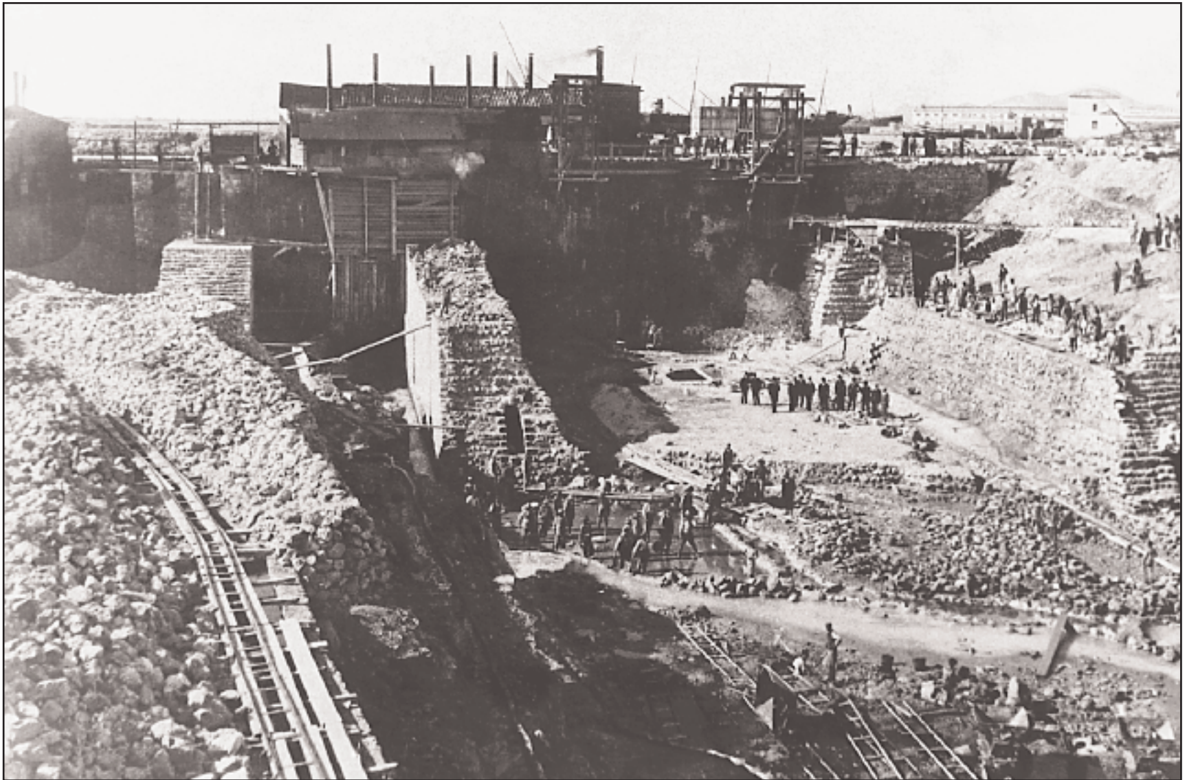
Οι δεξαμενές ελλιμενισμού Βασιλειάδη, απετέλεσαν ένα από τα μεγαλύτερα έργα της πόλης στην αλλαγή του αιώνα. Σε μια σπάνια φωτογραφία διακρίνονται οι θεμελιώσεις, κάτω από το επίπεδο της θάλασσας και το όρυγμα ενώ στο βάθος διακρίνεται η βιομηχανική ζώνη. (Αρχείο Γιάννη Χατζημανωλάκη)
