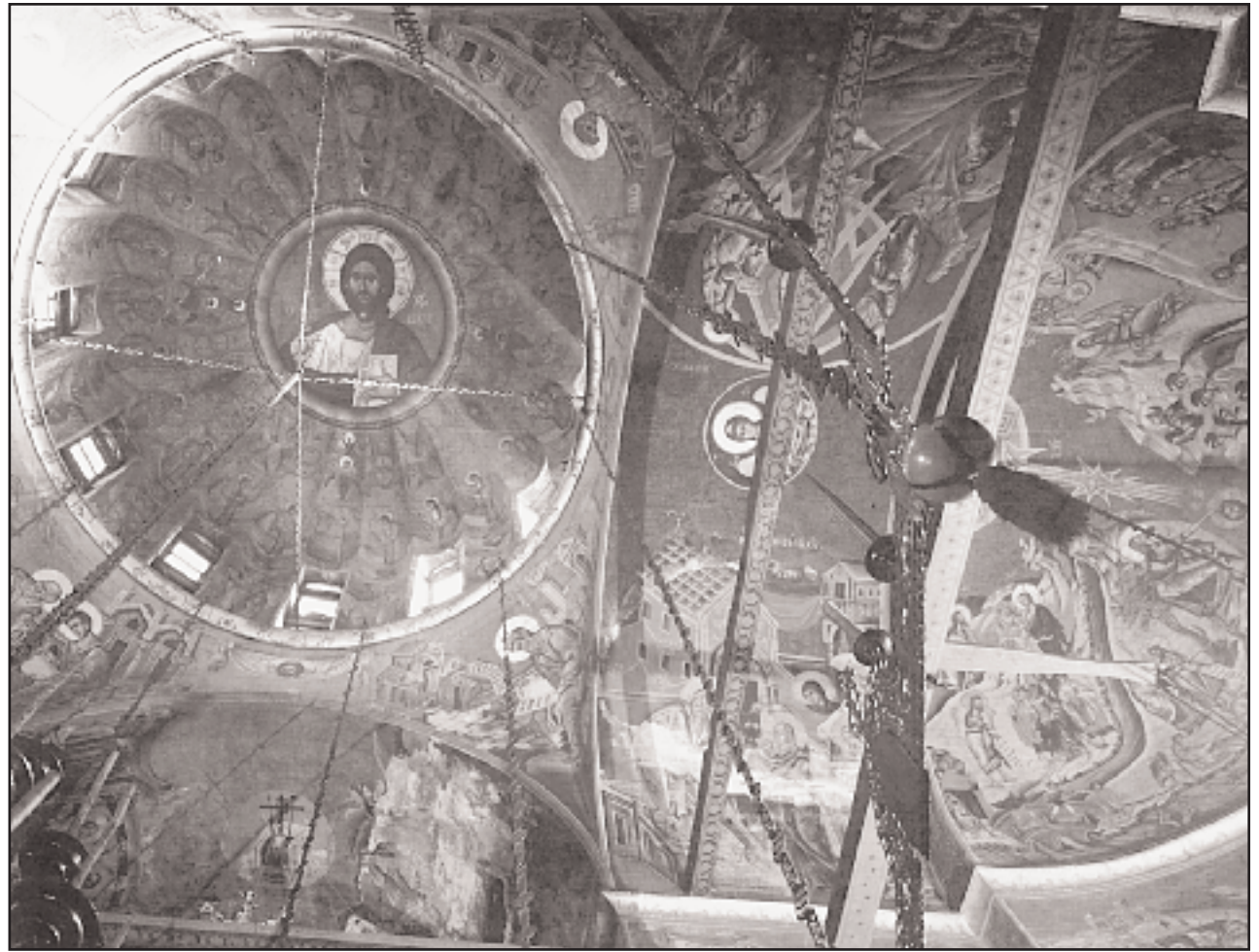
Ο κεντρικός τρούλλος και τμήμα του νότιου χορού στο καθολικό της Ιεράς Μονής Χιλανδαρίου, στο Αγιον Ορος. (Φωτ.: ΚΕΔΑΚ).
