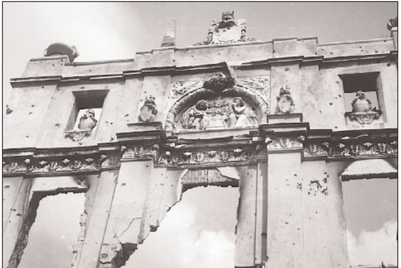
Ο,τι απέμεινε από το θαυμάσιες αρχιτεκτονικής κτίριο του επισκοπείου της ορθόδοξης επισκοπής Ζαχουμίου και Ερζεγοβίνης στο Μόσταρ, μετά τους βομβαρδισμούς των Κροατών το 1992. (Φωτ. Αθ. Χατζή)
