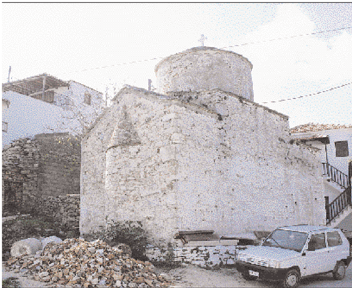
Η Χριστού (Γεννήσεως Χριστού) από ανατολικά. Βρίσκεται στο Παλιό Χωριό μέσα στο μεσαιωνικό τείχος.
