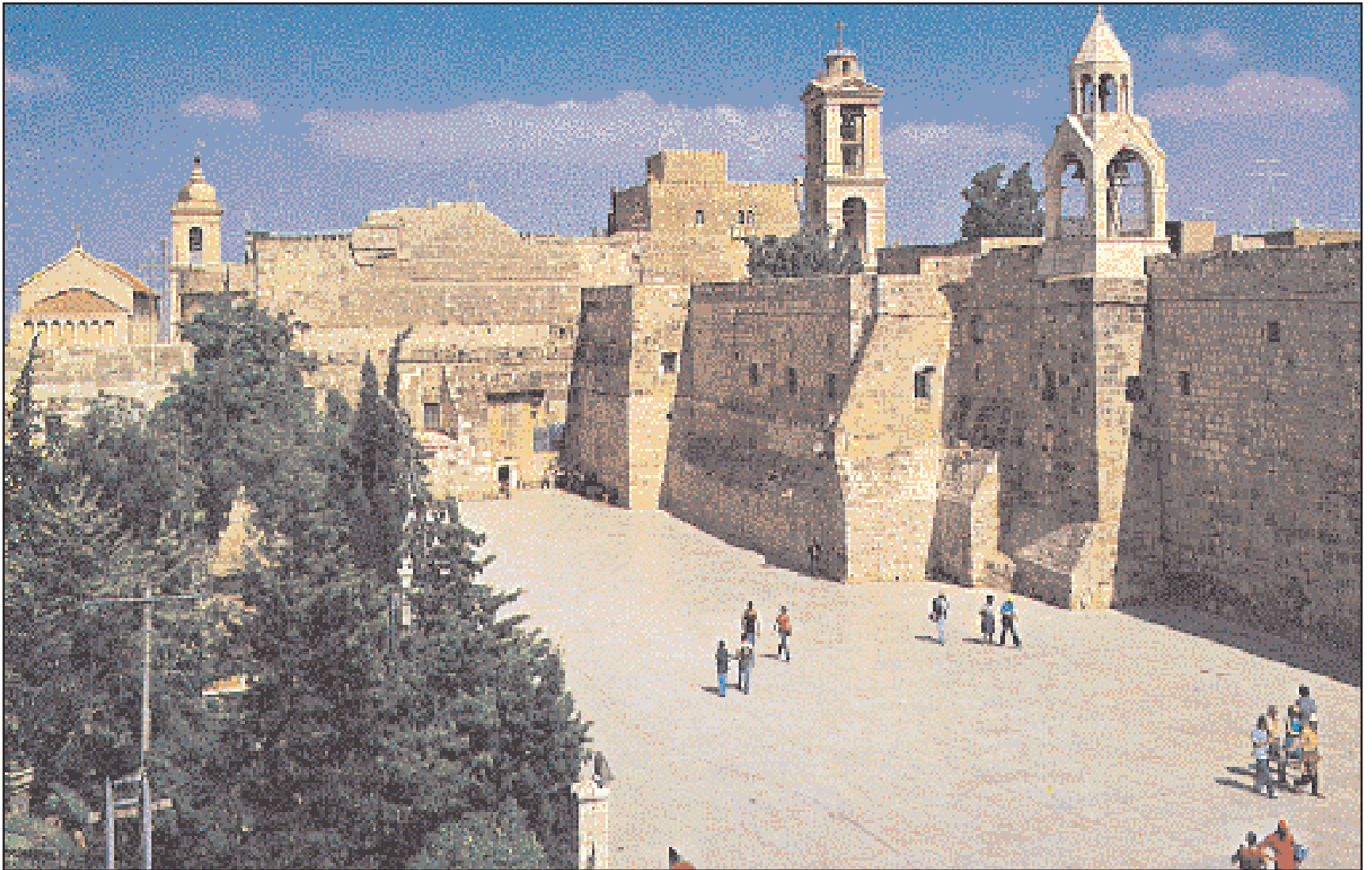
Βηθλεέμ. Η πλατεία με τη δυτική πλευρά της Βασιλικής της Γεννήσεως. Η αλλοιωμένη ιουστινιάνεια δυτική πρόσοψη με το μικρό άνοιγμα εισόδου (από την εποχή της τουρκοκρατίας) είναι φανερή. Αριστερά το λατινικό μοναστήρι, στο κέντρο δεξιά ο πύργος των Ελλήνων και δεξιά το αρμενικό μοναστήρι.
