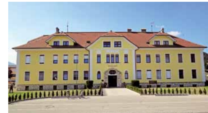
Die Volksschule wurde energetisch saniert und damit werden in Zukunft wesentliche Energiekosten eingespart
