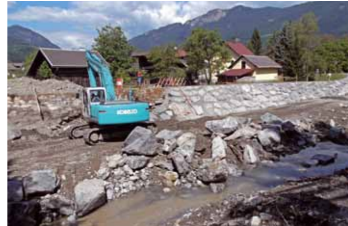
Hochwasserschutzbaumaßnahmen bei der Valentin
