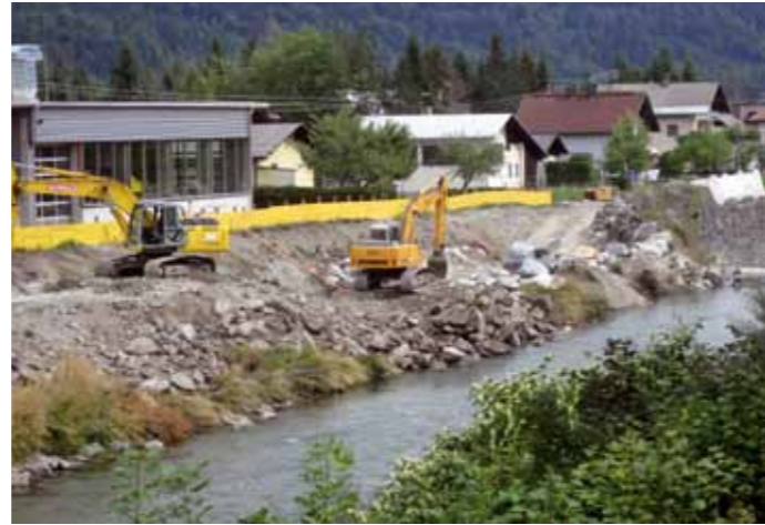
Die Hochwasserschutzbaumaßnahmen gehen in diesem Jahr sehr zügig voran
