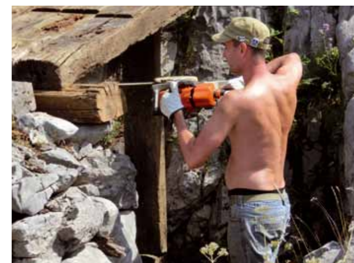
Bau einer Eindeckung
