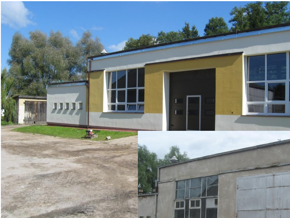
Szkoła przed i po termomodernizacji
