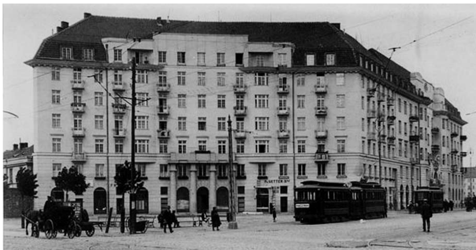
Kamienica proj. Zygmunta Tillingera stanowi optyczną przeciwagę dla budynku Centralnego Akademika Bratniej Pomocy, fot. www.warszawa1939.pl, za: O. Budrewicz „Warszawa Przedwczorajsza”. Olszanica 2004
