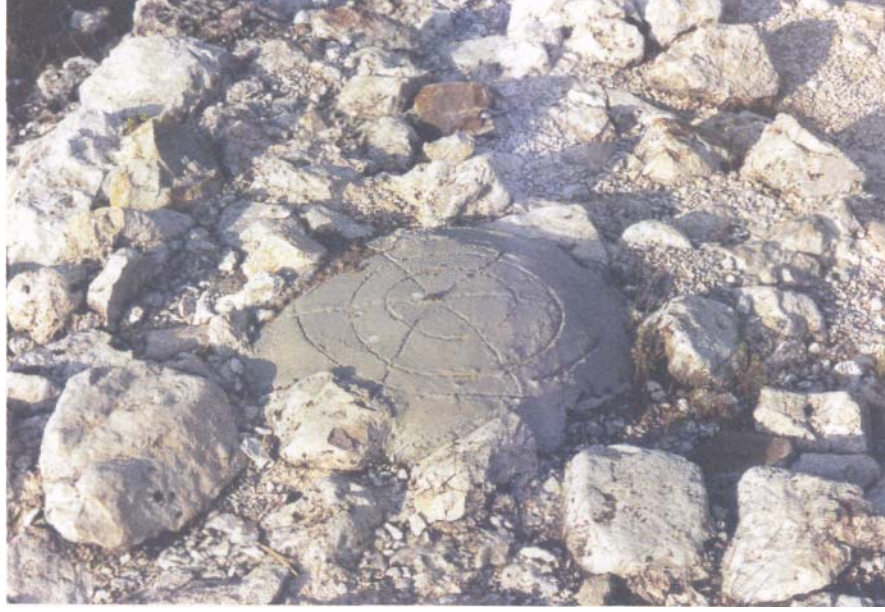
Köprü üzerindeki Tapu Kadastro işareti
