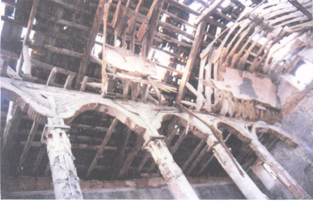
Ayastefanos Kilisesi onarımdan önce 1990
