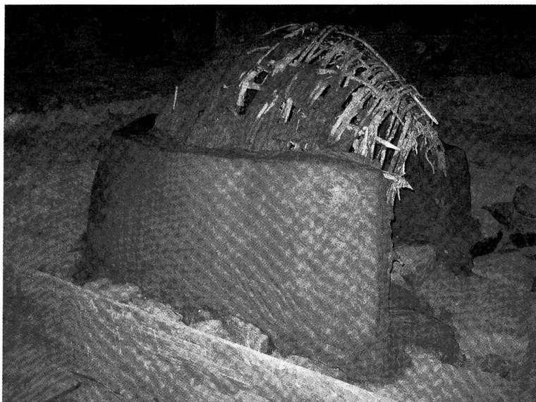
Kuva 6. Vain ulkopuolelta savettu uuninkehikko rakennusvaiheessa. Kuva: E. Salmi.
