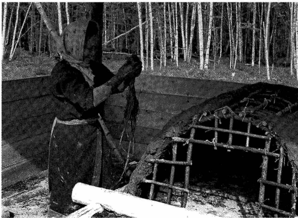
Kuva 8. Hantilainen ulkokäyttöön tehty savikupoliuuni tekeillä Sorovskie ozjorassa sijaitsevassa perinnepihassa (Kuva: Malyškin et al. 2006).
