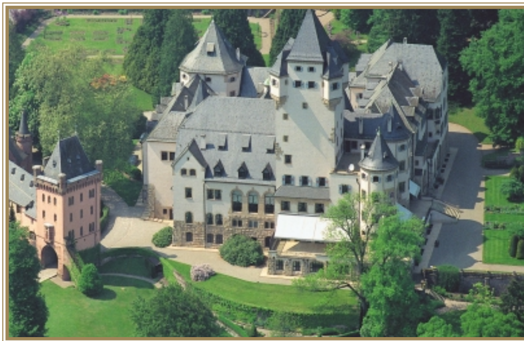
Vue aérienne du Château de Berg
