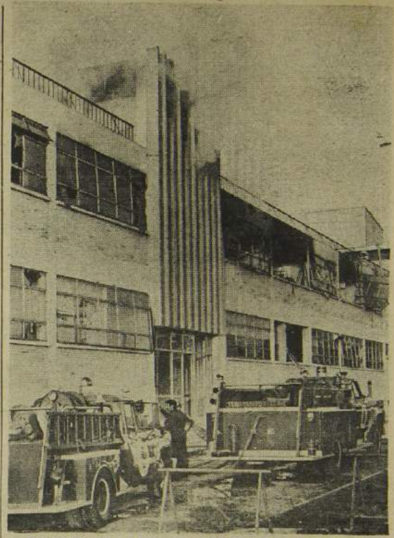
INCENDIO de los laboratorios del INCAP con cuantiosas pérdidas.
