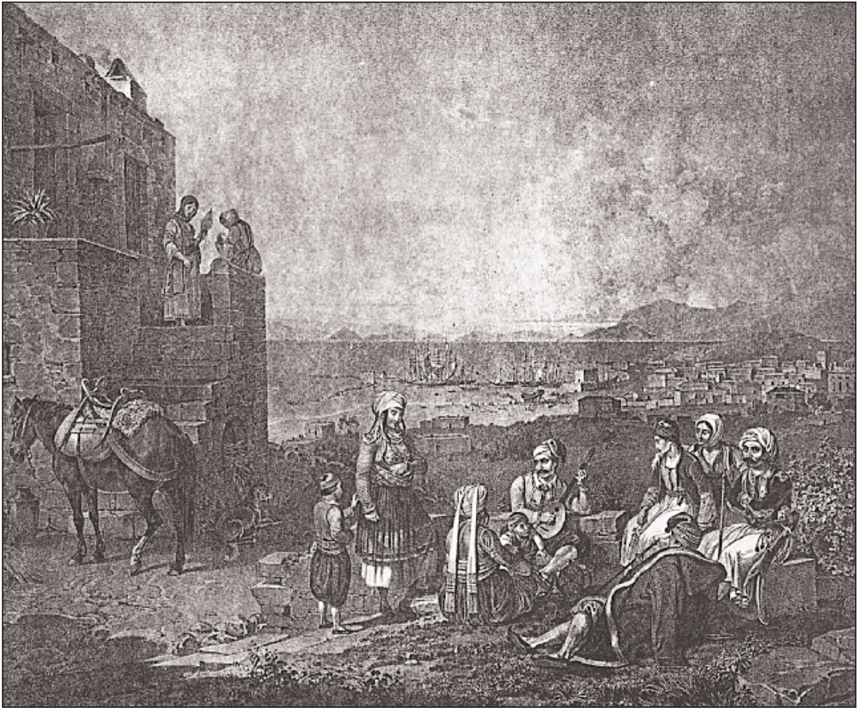
Εικόνα καθημερινής ζωής στην Αίγινα την εποχή της αφίξεως του Καποδίστρια. Στο βάθος, η πόλη της Αίγινας και το λιμάνι. (Λιθογραφία από έργο του Κρατσαίζεν, συλλογή ΜΙΕΤ).
