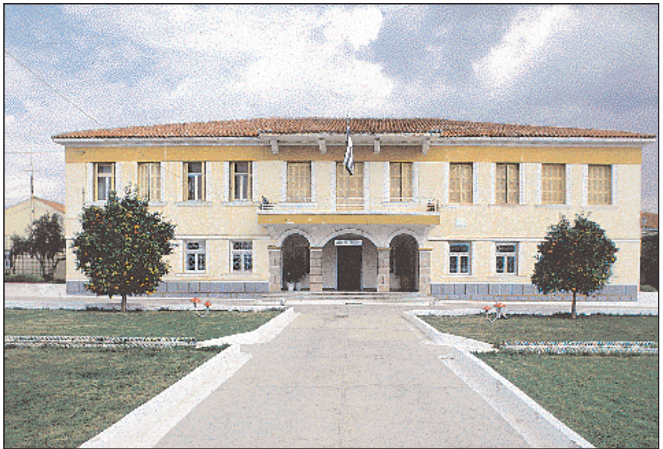
Οι αγροτικές, σήμερα, φυλακές της Τίρυνθας κατασκευάσθηκαν επί Καποδίστρια ως Γεωργική Σχολή. (Φωτ.: Κ. Βέργας)
