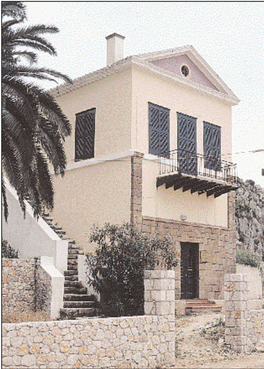
Το αναπαλαιωμένο κτίριο όπου στεγάζεται το Πνευματικό Κέντρο «Ιωάννης Καποδίστριας» στο Ναύπλιο, πρώην οικία Ζυμβρακάκη. (Φωτ. Κ. Βέργας)
