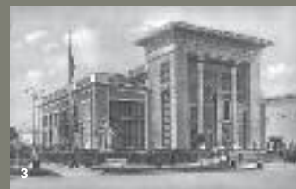
3 Архитекторы С.С.Дадашев и М.Л.Усейнов. Павильон «Азербайджанская ССР» на ВСХВ. 1939 Не сохранился
