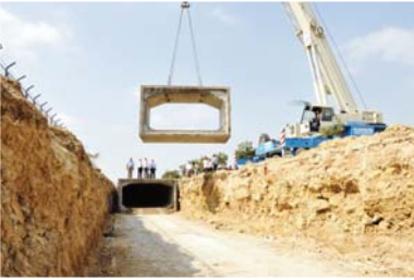
Uçak Mah. Yağmur Baks çalışması
