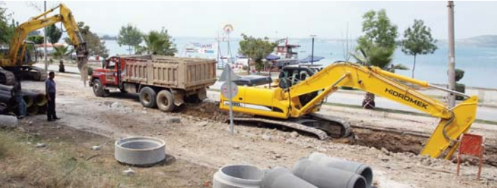
Adnan Menderes Bulvarı Kanalizasyon çalışması
