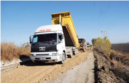
Dörtağaç Köy yolu asfalt çalışması
