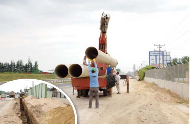
Karatay Yolu Çatalan Suyu altyapı çalışmaları
