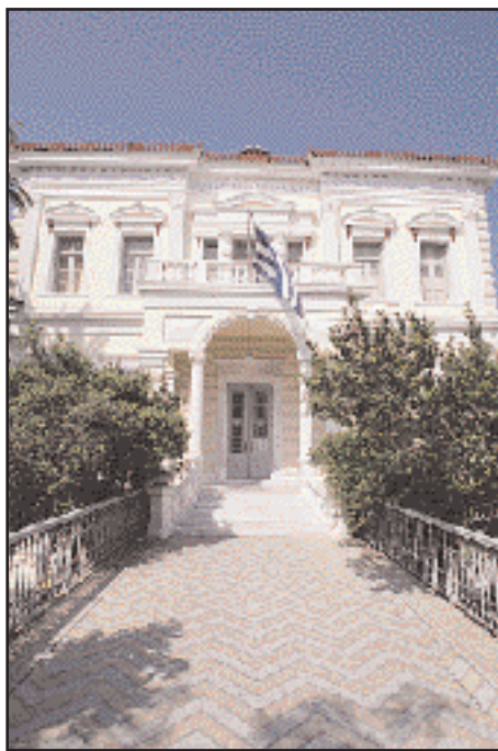
Το κτίριο της παλιάς Εμπορικής Σχολής χρησιμοποιείται σήμερα για τη διδασκαλία και τα ηλεκτρονικά εργαστήρια του Μαθηματικού Τμήματος (φωτ.: Βασ. Βαλή).
