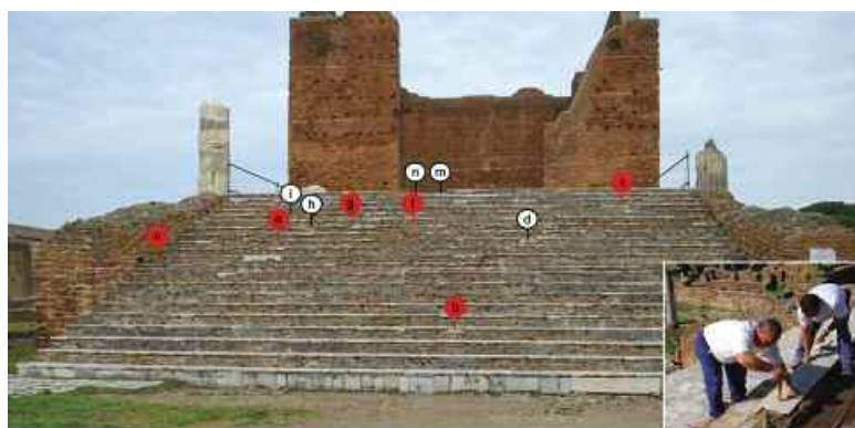
Capitolium, lavori di manutenzione della scalinata (aprile 2010)
