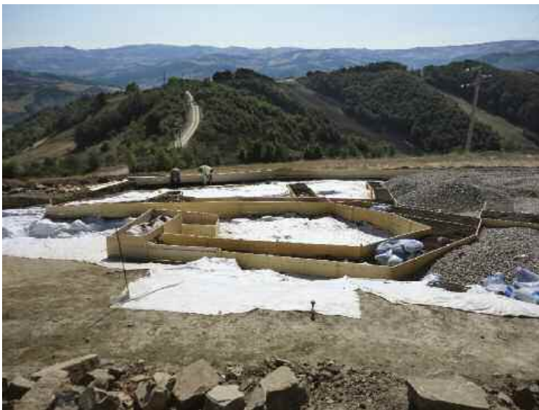
"Foiانو di Valfortore (BN), Parco Eolico in località Aria Sartori: Copertura e protezione dell'area dopo lo scavo"
