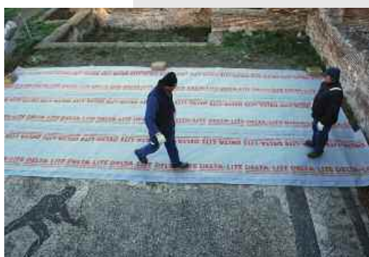
Terme di Nettuno. Protezione stagionale dei mosaici con teli idrorepellenti ad elevata traspirabilità.
