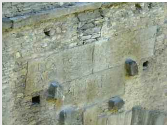
Veduta del prospetto nord del ponte acquedotto- foto S. Pinacoli
