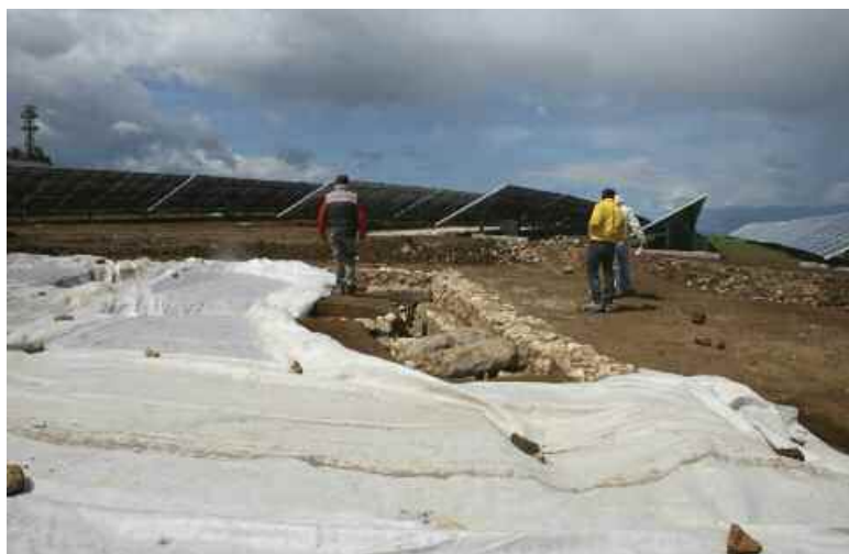
Eboli (SA), Parco Fotovoltaico in località Monti di Eboli: copertura e protezione dell'impianto santuarioale di età repubblicana
