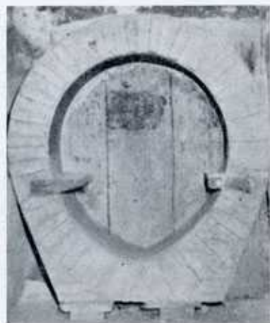
122 - Sagome esistenti nel cantiere comunale della Divisione Fognature; da sinistra: collettore medio, emissario di Cuma, scaricatore di Coroglio, collettore alto.
