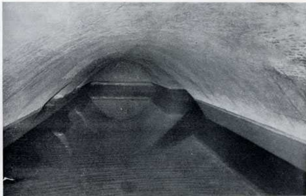
109 - Serbatoio di Capodimonte: vasca scavata nel tufo (lunga 250 m ca., alta m 10 ca.).
