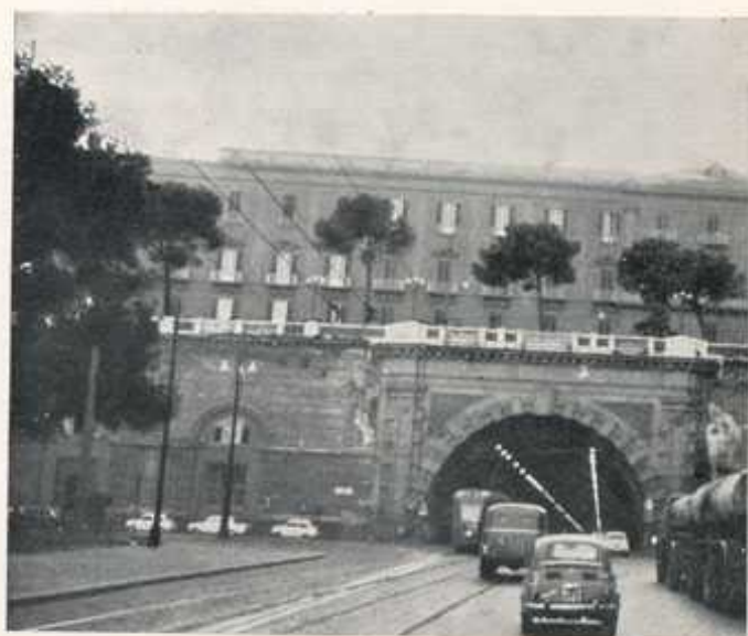
60 - Imbocco della galleria della Vittoria a via Acton
