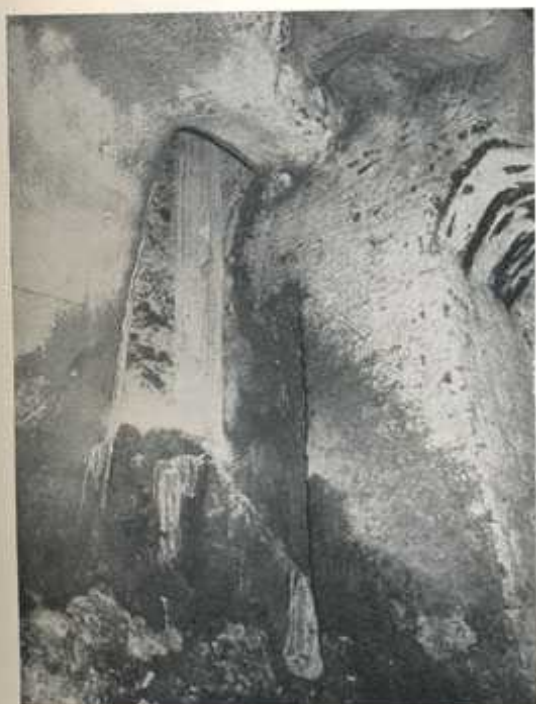
39-40 - Cavità a via Montesanto 59; in fig. 40, particolare allo sbocco di un pozzo adoperato, secondo la consuetudine corrente, per scarico di materiale di rifiuto.
