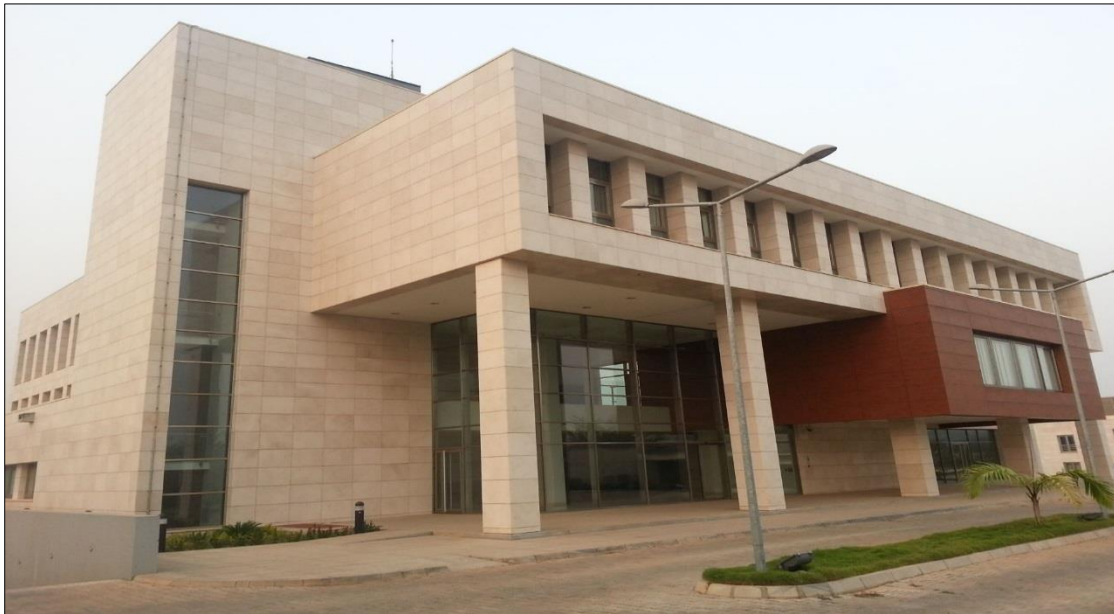
Abuja Büyükelçiliđi Kançılarya Binası
