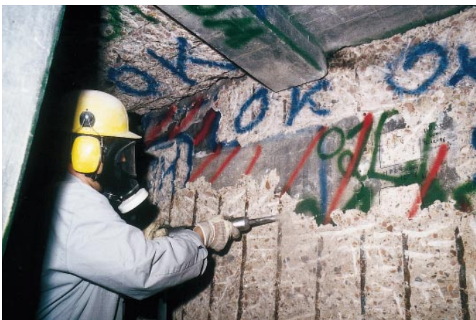
Abb. 1: Dekontamination der Wandflächen durch Abtragen der Oberfläche mit Abbauhämmern
