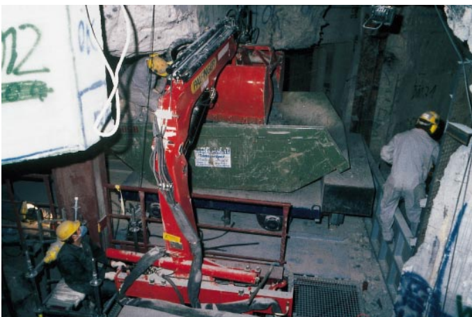
Abb. 5: Schuttverladung auf der Verschiebbühne auf Kote ± 0,0 m
