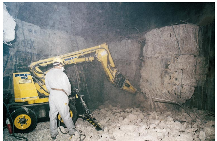
Abb. 6: Schlitz eines Wandsegmentes als Vorbereitung für die Messung an der Rückseite
