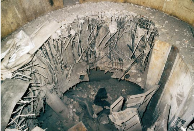
Abb. 3: Biologisches Schild nach der Sprengung
