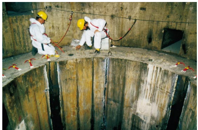
Abb. 2: Vorbereitung der Sprengung zum Rückbau des Biologischen Schildes
