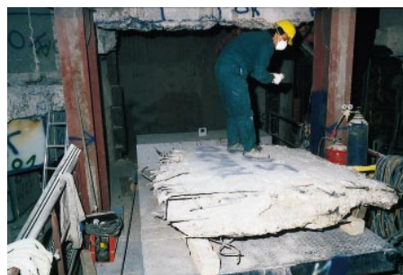
Abb. 9 bis 14: Trennen, Umlegen, Vertikaltransport und Ausschleusung eines Wandsegmentes
