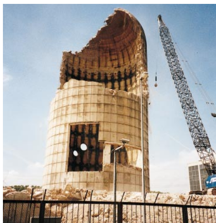
Abb. 16 bis 20: Abbruch des Reaktorgebäudes mit dem Seilbagger
