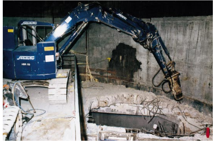
Abb. 4: Abbrucharbeiten mit dem elektrisch betriebenen Hydraulikbagger
