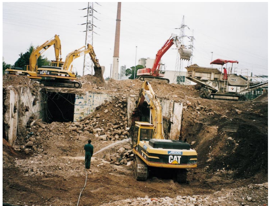
Abb. 22: Abbruch der Keller und Aufbereitung des Abbruchmaterials
