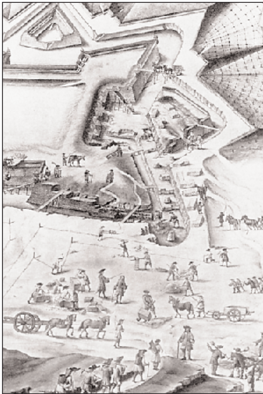
Ένα εργοτάξιο οχύρωσης, στη φάση οικοδόμησης καρδιάσχημου προμαχώνα και εξόρυξης ξηράς τάφρου. Τέλη του 17ου αι. Giraudon, Musée des Plans - Reliefs, Παρίσι.
