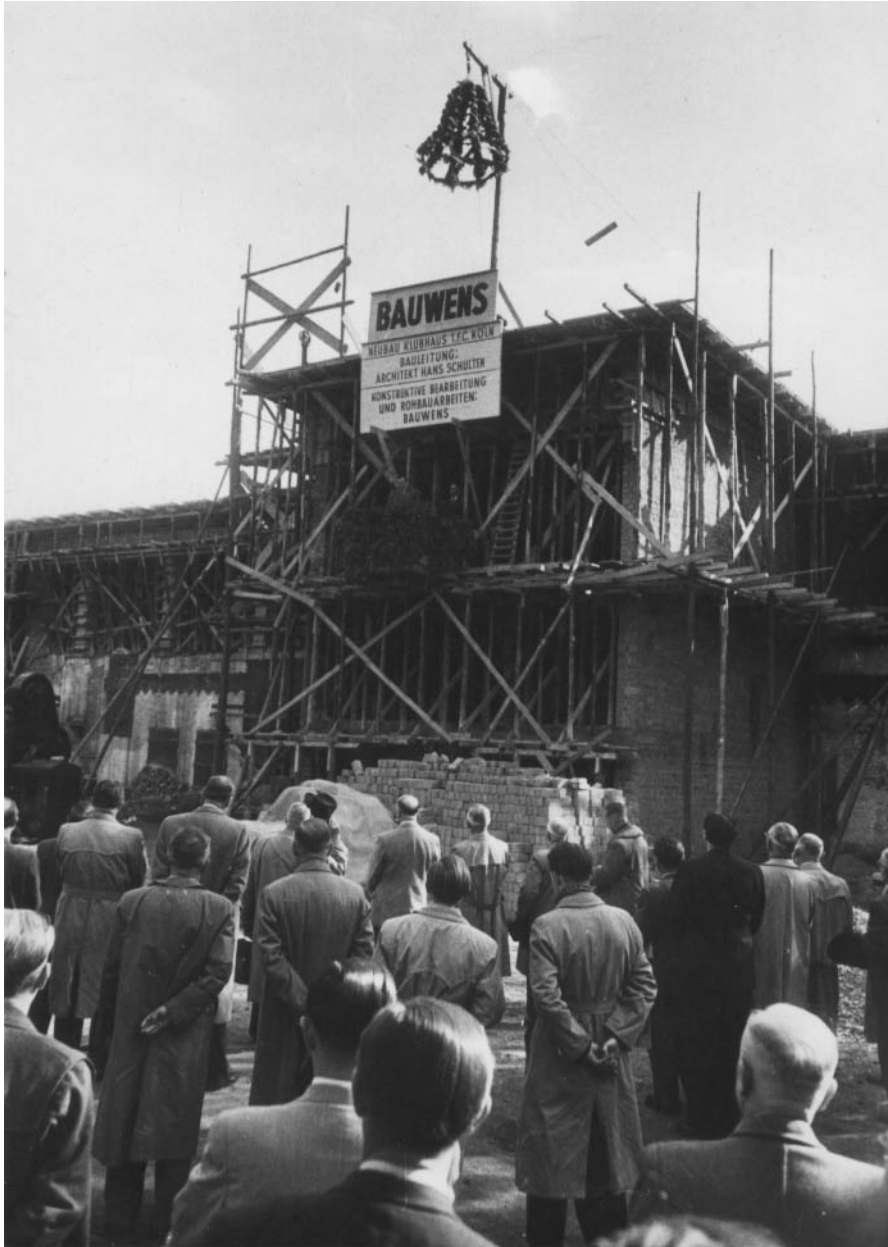
Abbildung 5: Richtfest des „Geißbockheims“ des 1. FC Köln auf dem Gelände an der Berrenrather Straße, 1950 (Kölner Sportgeschichte e.V.)
