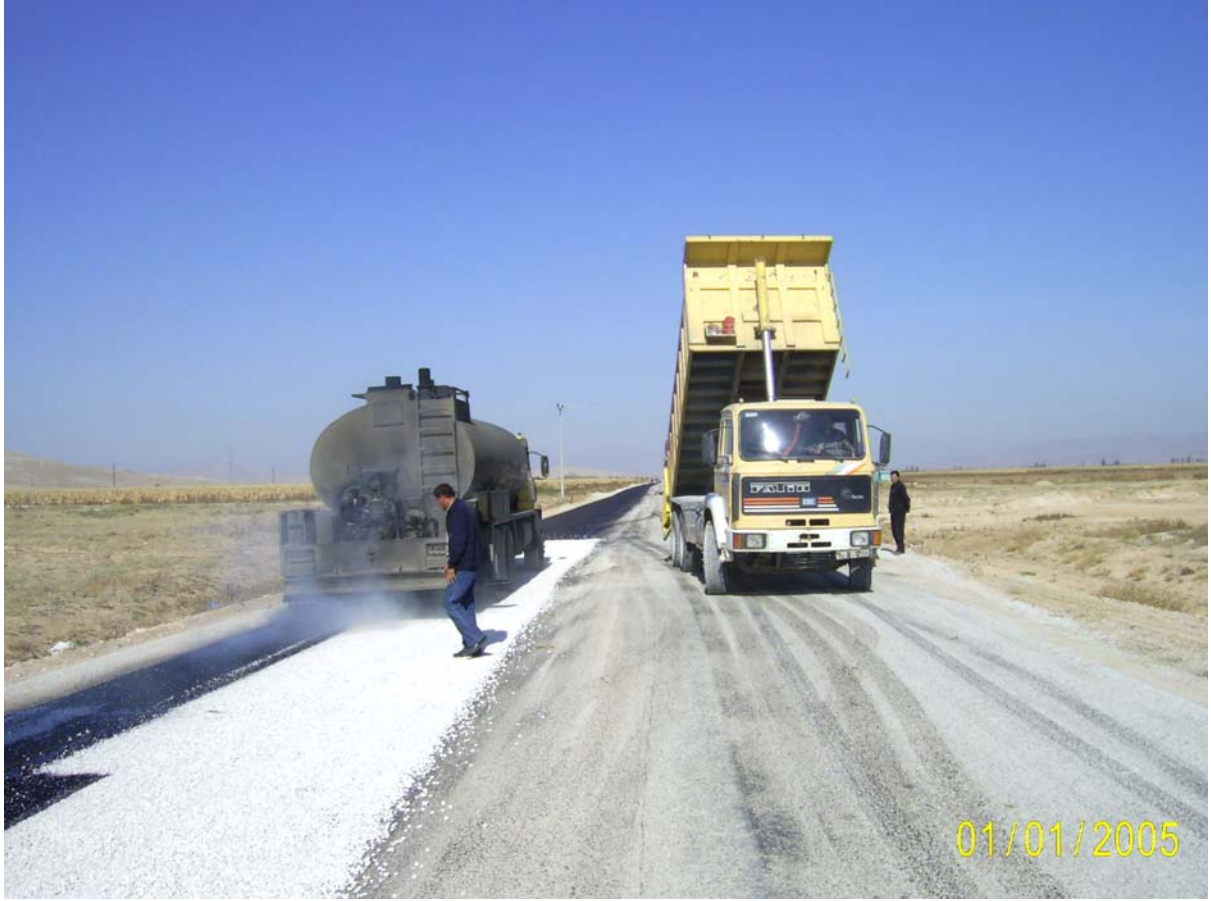
Şekil.L.1. Karaman-Merkez-Mesudiye Köyü Asfalt Çalışması
