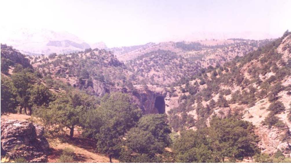
Resim.G.2: Doğa Köprü (Taşköprü)
