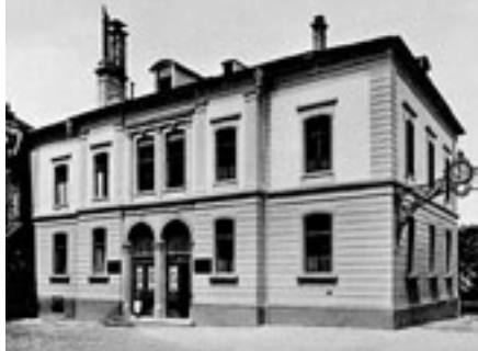
Toggenburger Bank in Lichtensteig.
