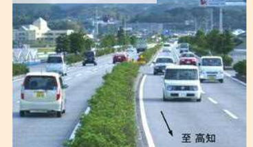
南国バイパス 土佐山田地区 (平成11年度 4車線完成供用開始)
