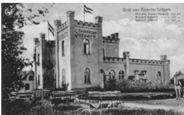
■ fot. Rybnica - nieistniejący zajazd Reibnitzer Südpark
