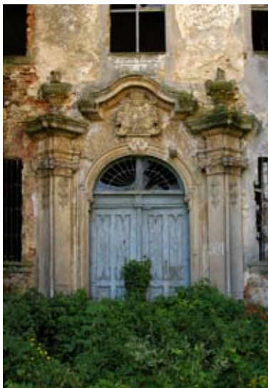
fot. Czerńczyce - portal wejściowy pałacu
