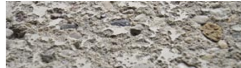
Bild 3: Abgewitterte Teilfläche eines Prüfkörpers
