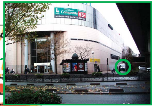
▲ Site côté Nord du centre commercial « Bel-Est ».
