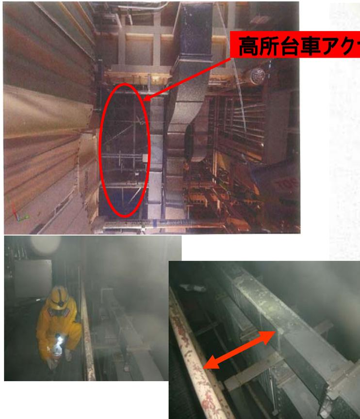
作業エリア確認(干渉物確認、装置設計のための寸法測定等)は、人が現場に立ち入りメジャー等で実測
