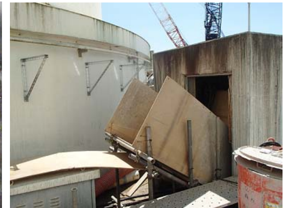
ペントハウス部 氷投入シューター設置状況 (8/6撮影)
