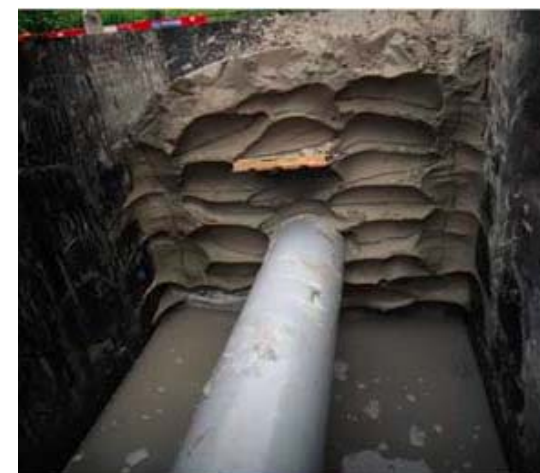
材料投入後土嚢撤去状況
