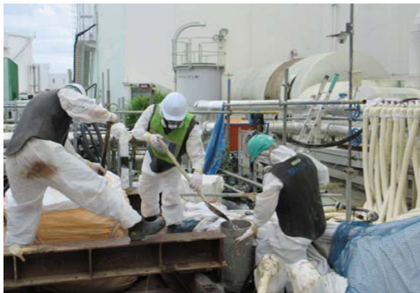
氷の試験投入状況 (K3孔より投入:7/24撮影)
