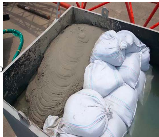
材料投入後、水抜き中状況
