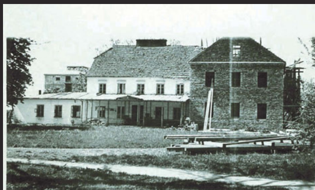
Przebudowa domu zakładowego 1948-1949
