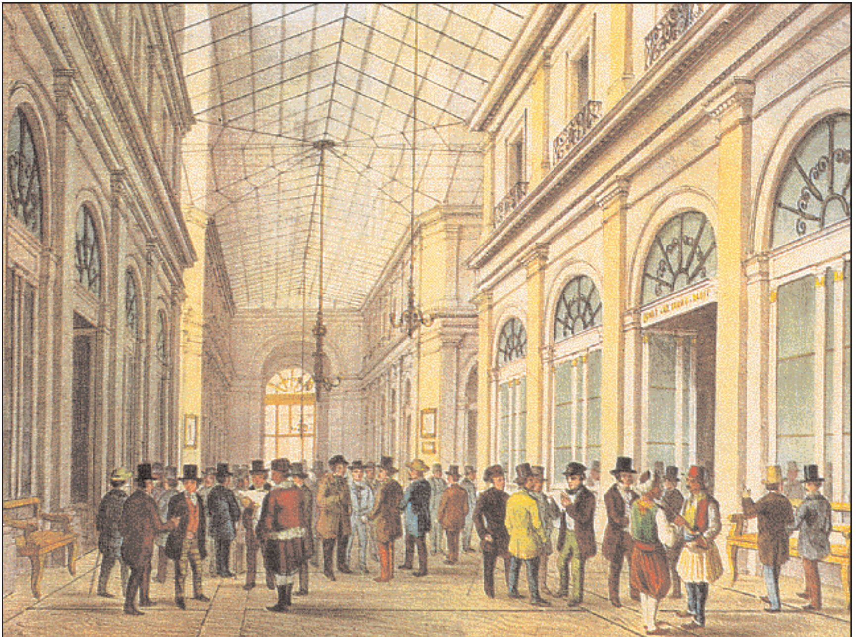
Η φημισμένη στοά Τερτζεστέο της Τεργέστης. Δεξιά διακρίνεται η είσοδος του Αναγνωστηρίου των Λούντς.
