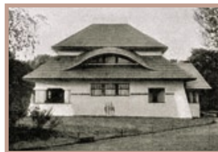
Elewacja boczna gmachu domu Sztuki.
