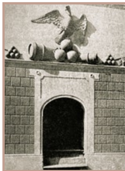
Wejście do dawnego arsenału.
