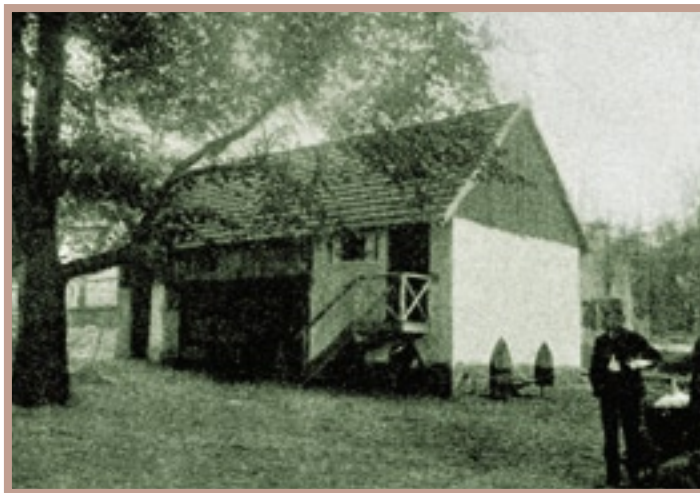
Zagroda włościańska. Śpichrz, wozownia i drwalnia. Fot. „Świtez”.
