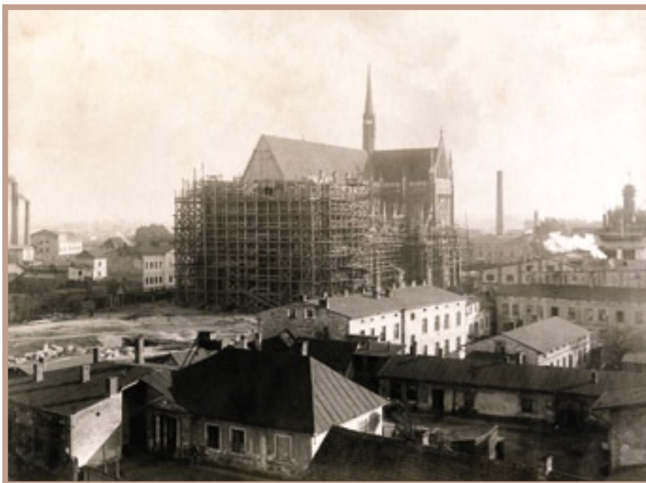
Budowa Katedry św. Rodziny. Fotografia z zakładu W. Wesółowskiego, 1909.
