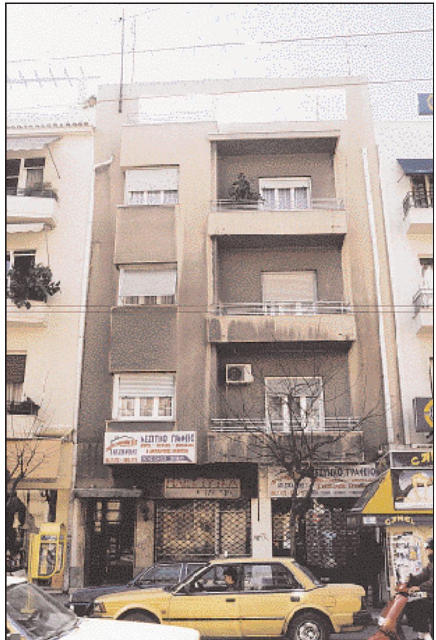
Πατησίων 225. Πολυκατοικία. Στενομέτωπο, κομψό κτίριο με κύριο χαρακτηριστικό την ελεύθερη δοκό (φωτ.: Γ. Μπαρδόπουλος).
