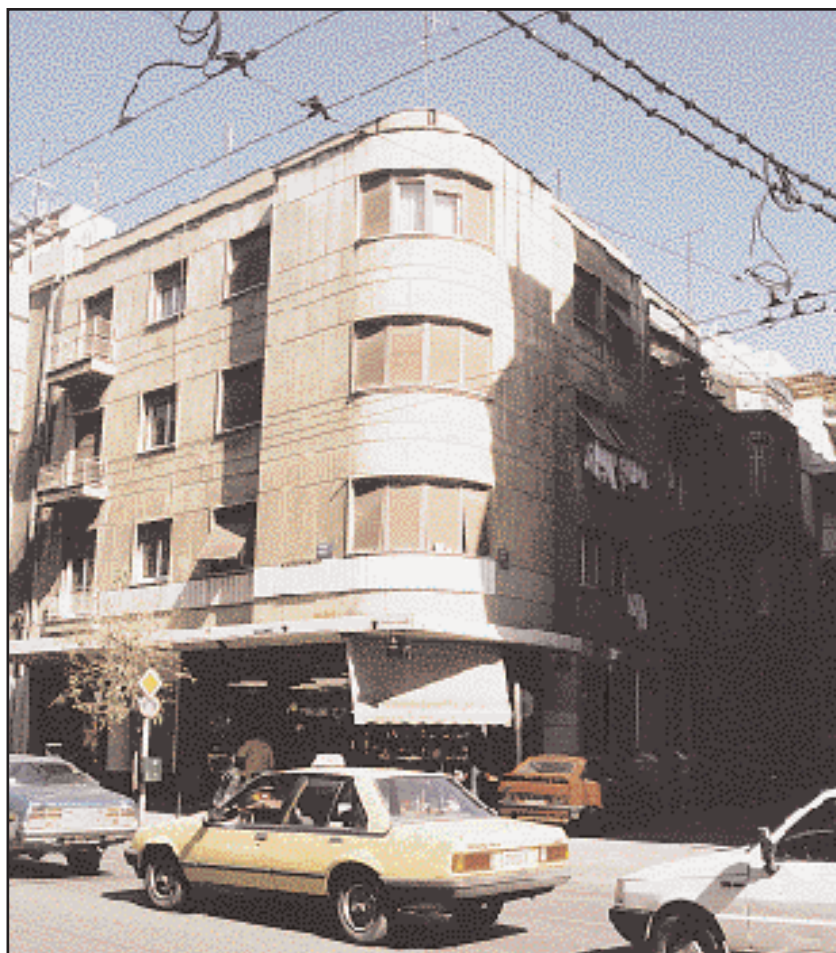
Πατησίων 186 και Θάσου. Πολυκατοικία Φάμπρα, αρχιτέκτων Θουκυδίδης Βαλεντής, 1938. Λιτή όψη με κυρίαρχο μορφολογικό στοιχείο και καμπύλη διαμόρφωση της γωνίας (φωτ.: Γ. Μπαρδόπουλος).
