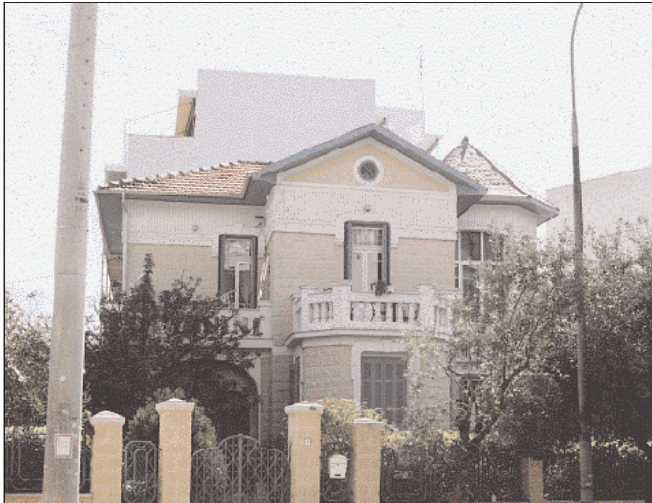
Χαρακτηριστικός τύπος σπιτιού στου Κυπριάδη, στην οδό Λασκαράτου: ειδικά διαπλασμένοι, ασβεστοपुरιτιακοί πλίνθοι καιτσιμεντόλιθοι και τετράρριχτες ξύλινες στέγες με κεραμίδια γαλλικού τύπου (φωτ.: Γ. Μπαρδόπουλος).
