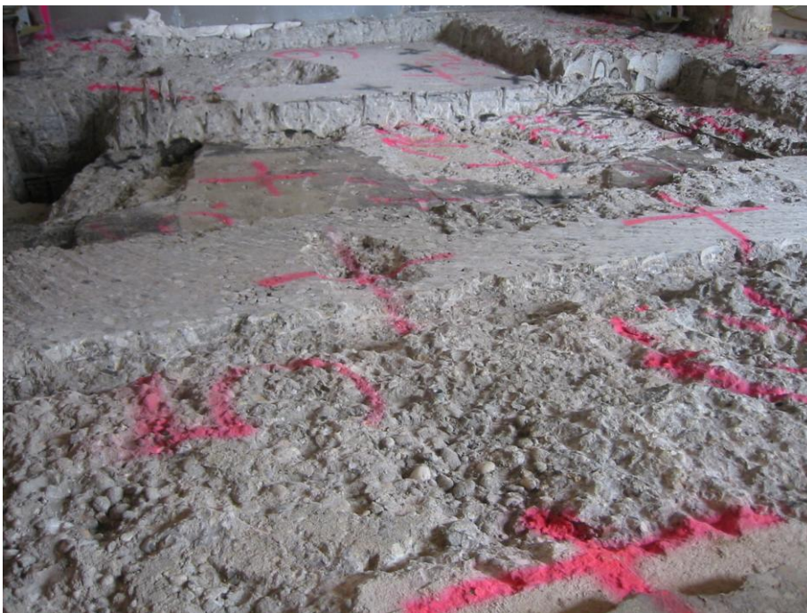
Abb. 3: Teilweise durch Oberflächenabtrag dekontaminierter Bodenbereich
