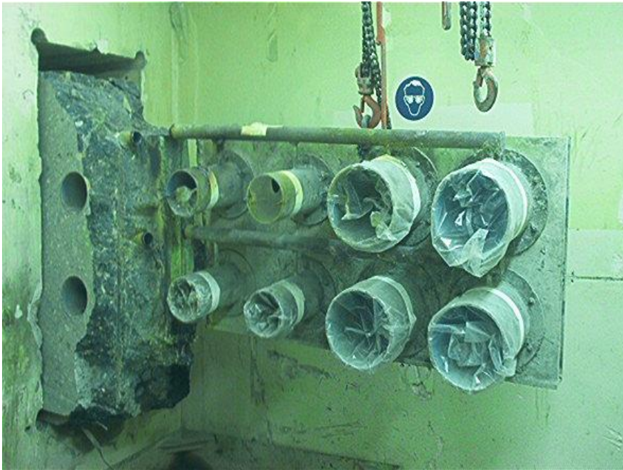
Abb. 2: Wand mit mehreren Rohrdurchführungen
