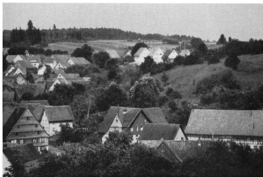
Blick auf das Oberdorf
