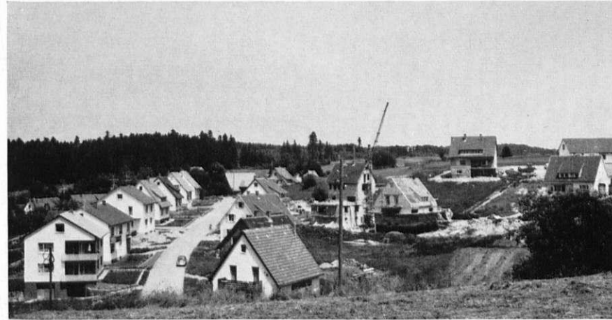
Neubaugebiet Haldacker, Baustelle mit Kran
