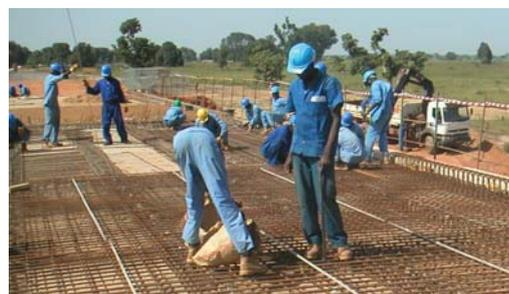
Ferrailage du tablier du pont sur la Tandjilé
