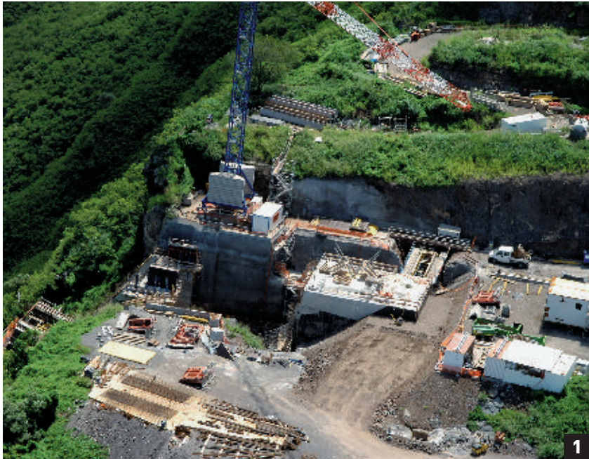
1 - Vue aérienne de la culée rive gauche sur le chantier de construction du viaduc de la Grande Ravine. 2 - Grande Ravine : vue de la brèche depuis la rive gauche.
