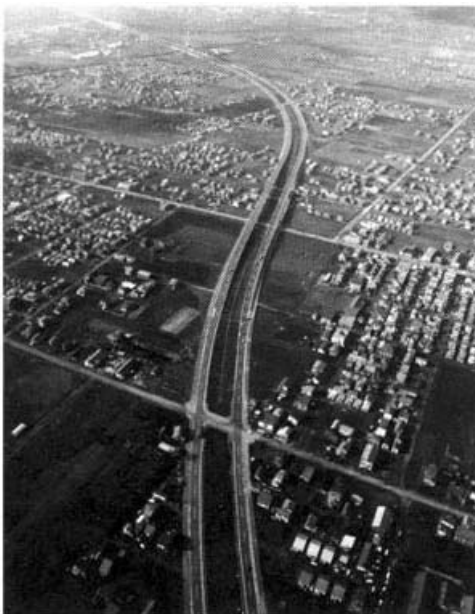
New Sapporo expressway Nouvelle auto-route de Sapporo
