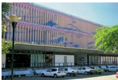
Edificio de Música.
