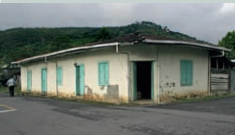
Vivienda de adobes.
