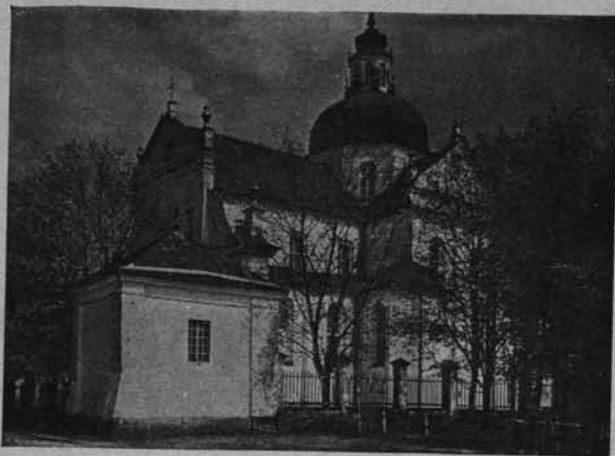
Ryc. 156. Kościół po-jezuicki w Nieświeżu Fot. J. Bułhak.
