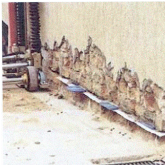
Figura 7 – Colocação de uma barreira estanque através de corte mecânico
