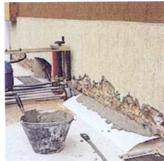
Figura 7 – Colocação de uma barreira estanque através de corte mecânico
