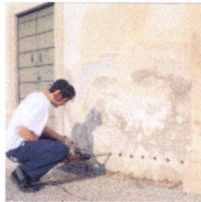
b) Execução dos furos
