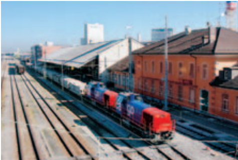
Aushub auf die Schiene: Basel St. Johann.
