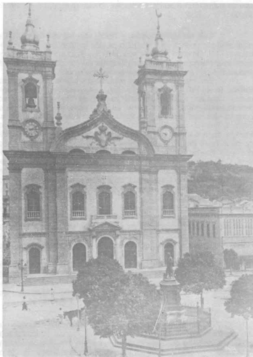
Fachada da Igreja de São Francisco de Paula, edificada em 1757-58. MIS
