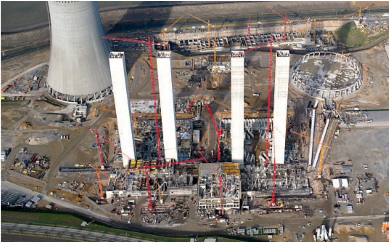
Baustelle des Braunkohlenkraftwerks BoA 2/3 in Neurath, eine Doppelblockanlage mit 2,2 GW elektrischer Leistung. Die mit dem Kraftwerksbau verbundenen CO 2 -Emissionen sind im Vergleich zu den Emissionen im Kraftwerksbetrieb vernachlässigbar klein.
